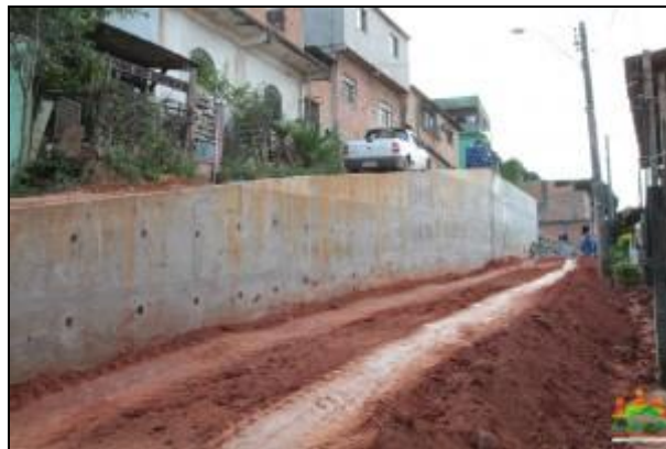
Figura 4 - Muro de arrimo contendo talude na cidade de Cariacica/ES
