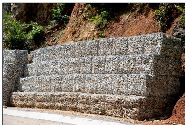
Figura 3 - Muro de arrimo
