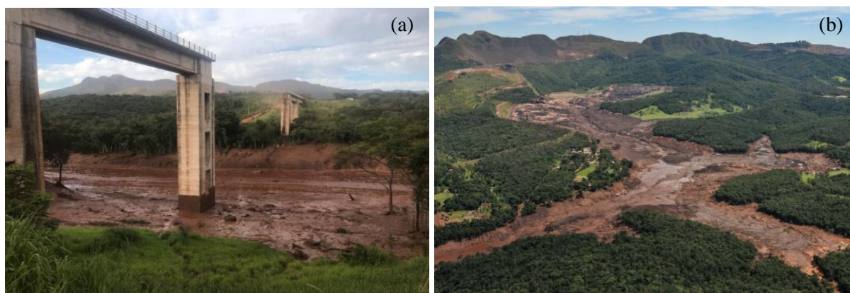
Figura 1 - (a) Danos à infraestrutura; (b) Área atingida pelo rompimento (IBAMA, 2019)
