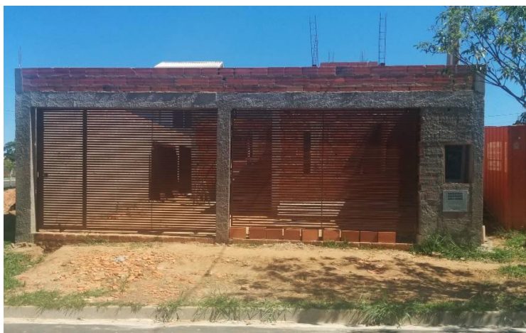
Figura – Foto da casa Nº 15 no Jardim Ibirapuera – 20/11/2016 (22°54'52.2"S 47°07'02.2"W; -22.914492, -47.117277) (Fonte: Próprio autor (2016))
