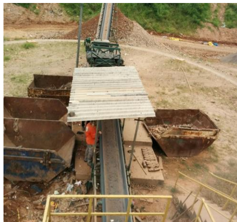
Figura 3 – Foto do processo de separação pós trituração, Unidade recicladora de materiais, Campinas, São Paulo (22°55'28.1"S 47°08'40.1"W; -22.924477, -47.144465) (Fonte: Próprio autor (2017))
