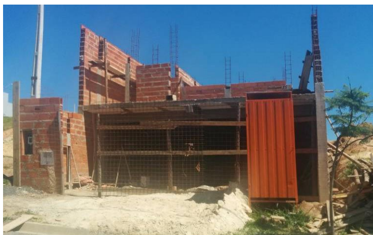
Figura 6 – Foto da casa Nº 111 no Jardim Ibirapuera – 20/11/2016 (22°55'06.7"S 47°07'04.2"W; -22.918529, -47.117833) (Fonte: Próprio autor (2016))
